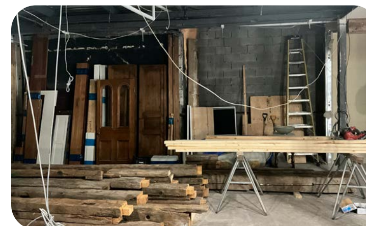
Matériaux spécifiés par l'architecte et entreposés par l'entrepreneur pour un futur réemploi sur place
